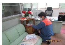
消防による緊急通報システム点検
