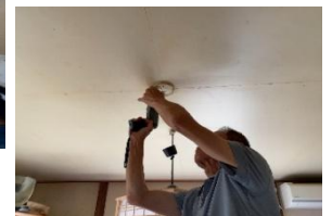
火災報知器の取付中
