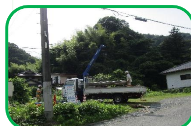
大平田の水質調査している現場
